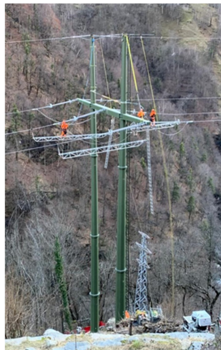
Abbildung 13: Fotos Mastersatz einer einsträngigen Trasse durch einen Stahlrohrmasten
