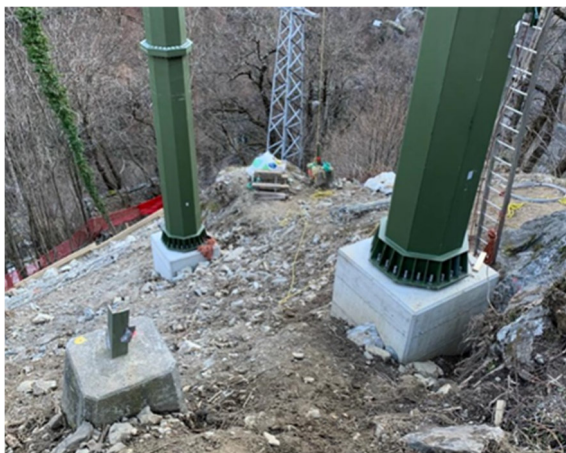
Abbildung 13: Fotos Mastersatz einer einsträngigen Trasse durch einen Stahlrohrmasten
